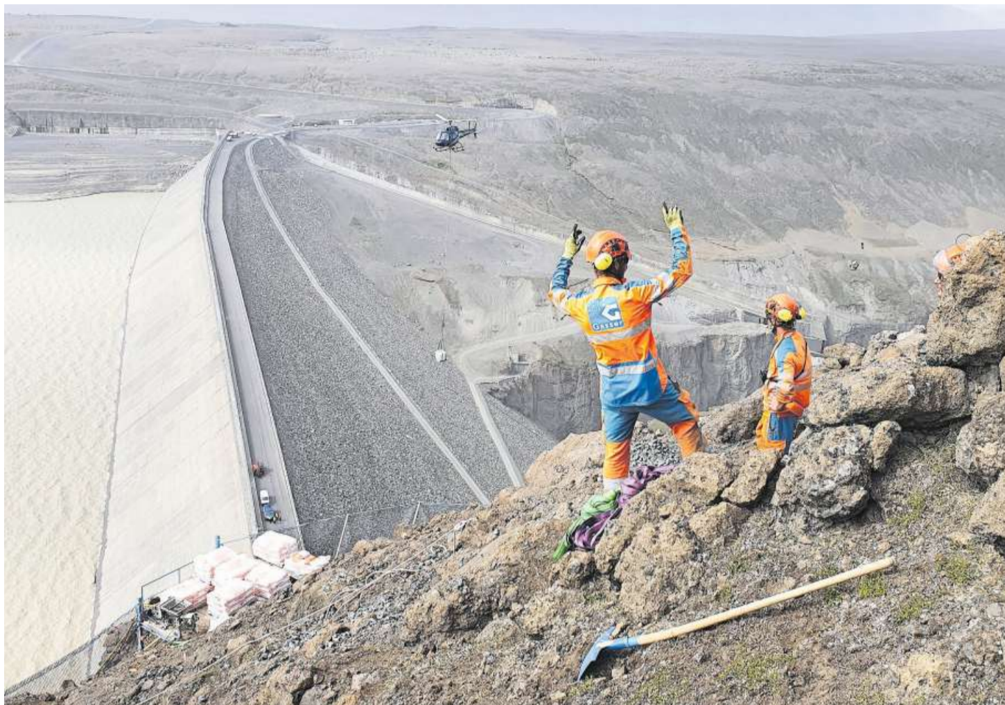
Ein Helikopter transportiert Material zu den Arbeitern aus Lungern am Fels. Im Hintergrund der Staudamm Kárahnjúkar.
